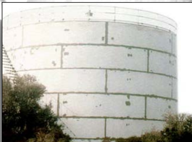
Cisterna per acqua Ø20.000 x Hf 15.000 Tank for water Ø20.000 x Hf 15.000
